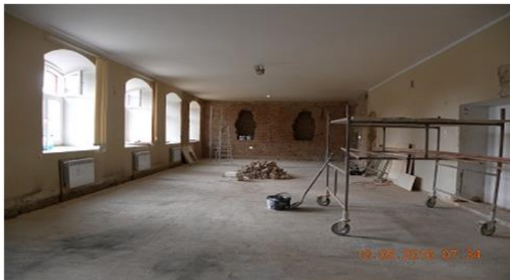
PRACE REMONTOWE OBIEKTÓW POKLASZTORNICH TRWAJĄ .
